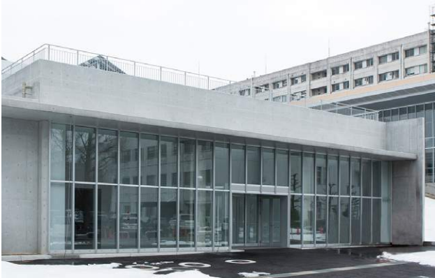
災害時拠点になる災害対策プラザ
