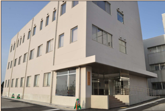
病院西側出入り口付近に完成した 総合臨床教育センター
